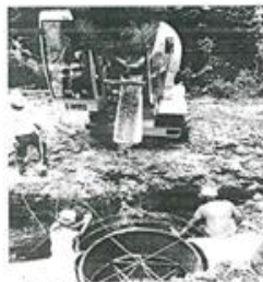
Figura 4 - Colado de concreto para pozo
