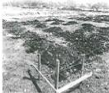
Figura 26 - Trazado de columnas
