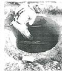
Figura 7 - Colado de concreto para pozo
