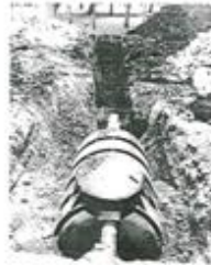
Figura 28 - Fosa séptica instalada.
