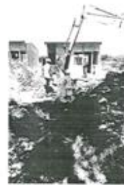
Figura 29 - Instalación de drenaje.
