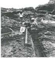
Figura 8 - Instalación de tubería portátil.
