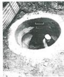
Figura 5 - Pozo pluvial
