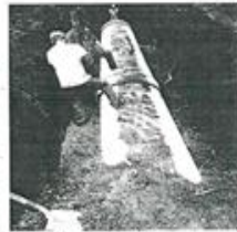
Figura 3 - Colocación de tubería
