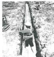
Figura 6 - Instalación de tubería sanitaria
